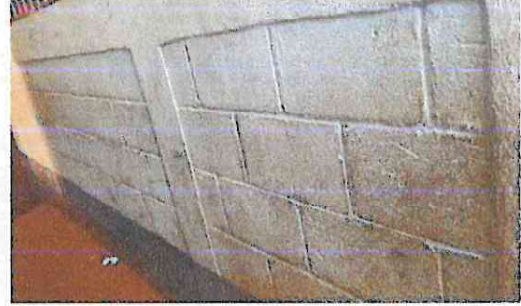
PINTURA EN MUROS EXTERIORES Y INFERIORES SALONES 1,2,3,4 Y 5
