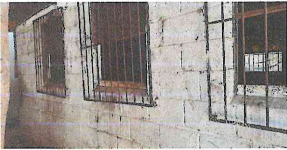
PINTURA EN MUROS EXTERIORES Y INFERIORES SALONES 1,2,3,4 Y 5
